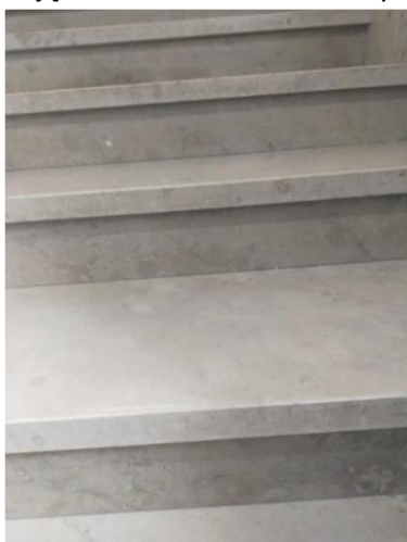
Zdjęcie nr 13: Schody wewnętrzne
